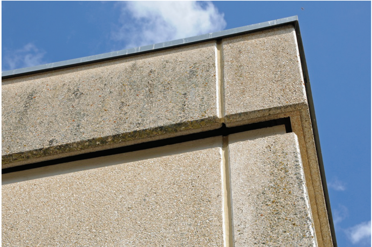
Abbildung 6: Detail der Dachhinterlüftung an der Sporthalle.
