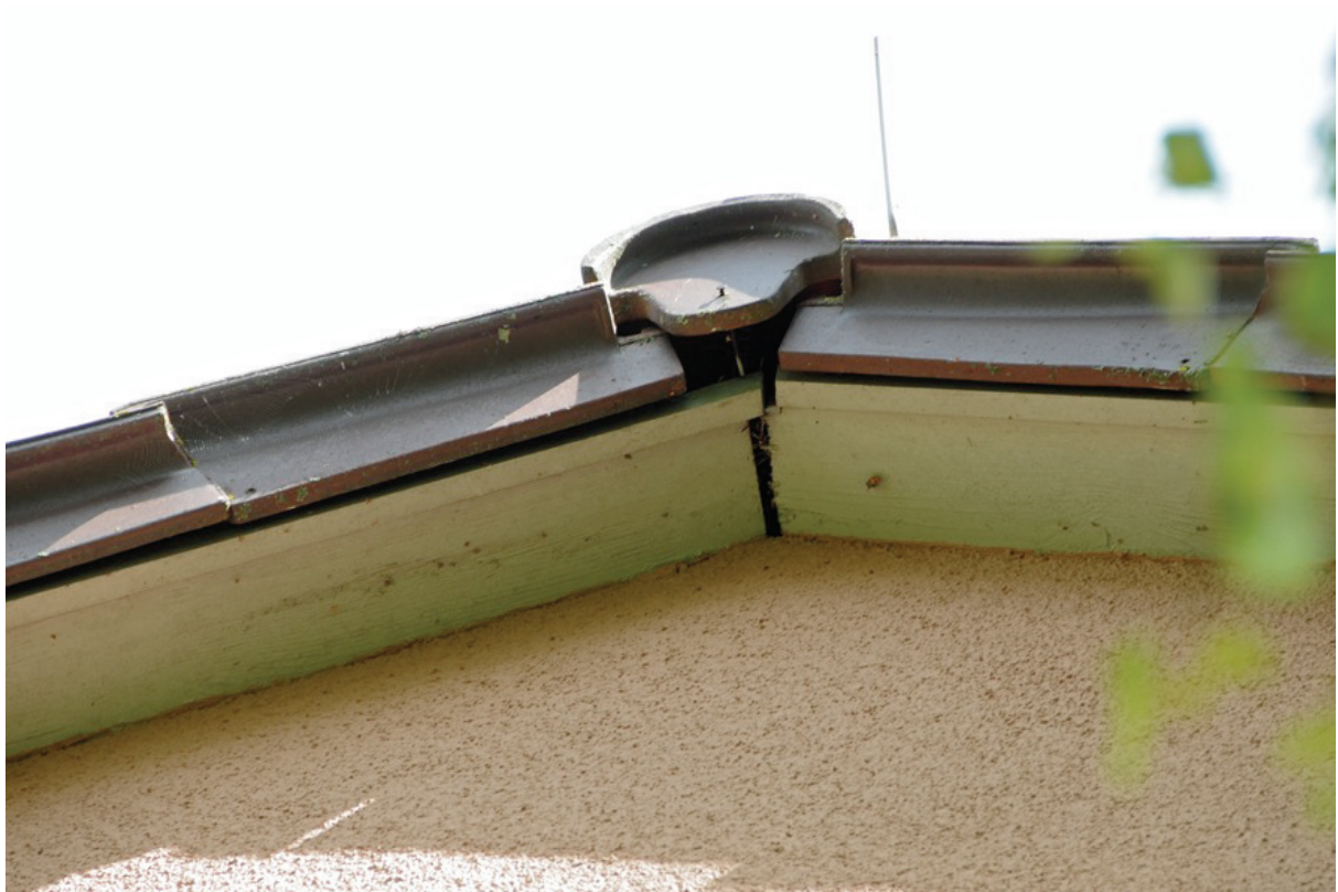
Abbildung 3: Quartierspalt im Firstbereich eines der ehemaligen Lazarettgebäude.
