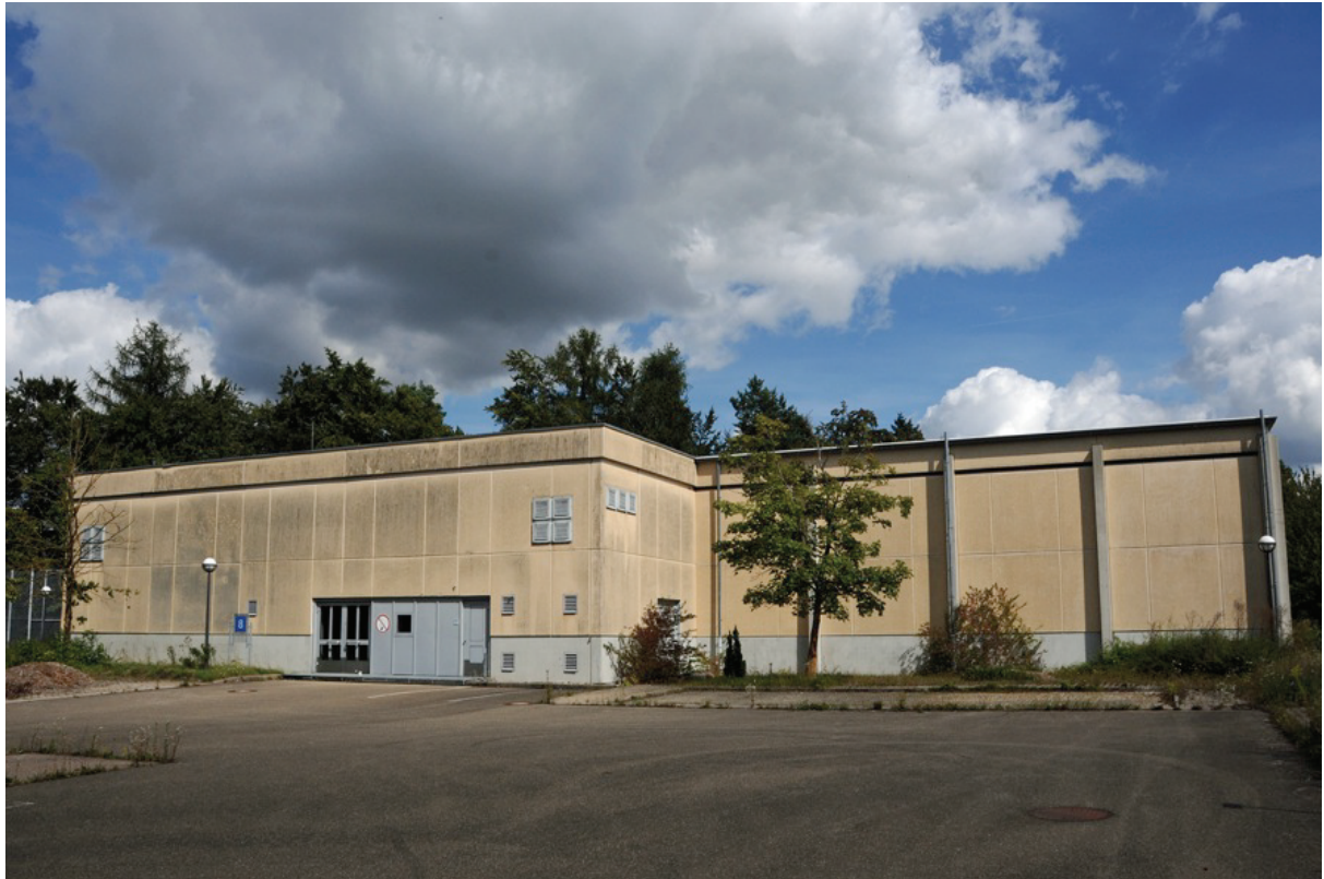
Abbildung 5: Sporthalle mit früherem Quartiernachweis der Zwergfledermaus in der Wandschale und der Dachhinterlüftung.
